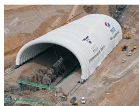
统气肋式气膜跨度限制的技术壁垒，成功突破56米超大跨度，开创了“柔性基建设”新范式。此前，中成空间已在新疆拜城项目中验证了205米最大跨度气承式气膜的技术成熟度，此次将气肋式结构的跨度推至新高度，再次彰显了
